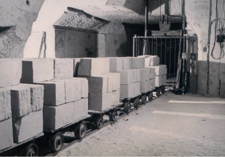
◀ AFBELDING 7: Lorries op smalspoor met blokken, beneden aan de blokkenschacht.
