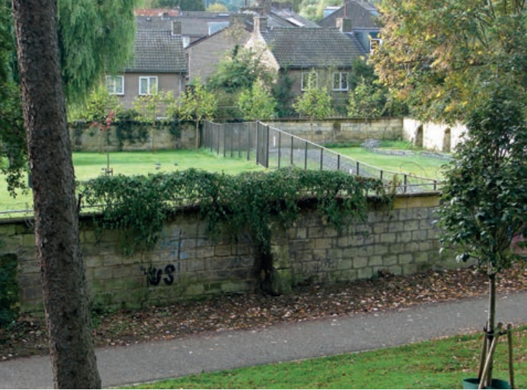
◀ AFBELDING 13: Ommuring zwembad Jekerdal in Maastricht. De enige plaats waar met zekerheid blokken van de Roothergroeve zichtbaar zijn.
